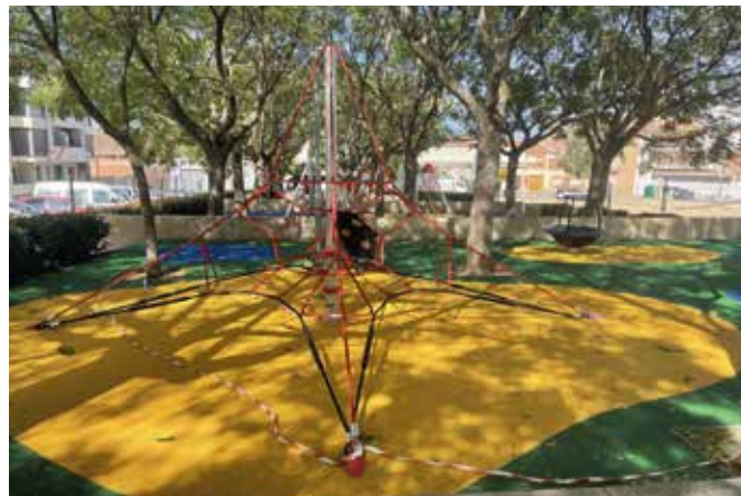
El Parc de la plaça Europa, després de les obres
