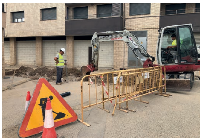
Les obres al carrer de Nostra Sra. de Montserrat
