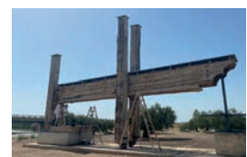
Els treballs de restauració de l'element de fusta
