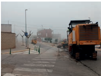
Maquinària treballant en les obres
